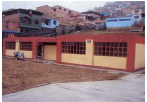
2011年8月16日 建設中の保育園園舎
