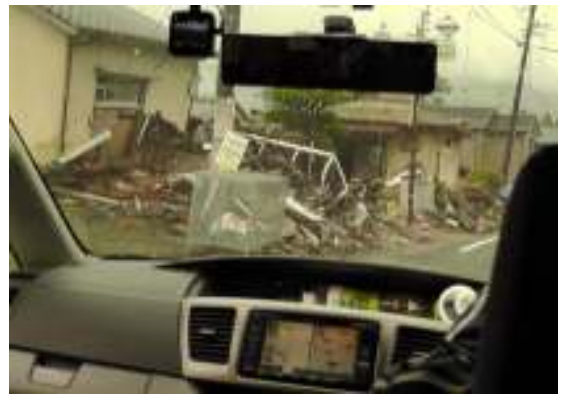
倒壊した住宅
